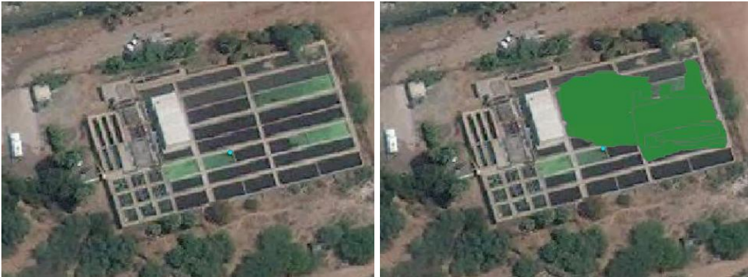
Planta de tratamiento Los Arroyos
